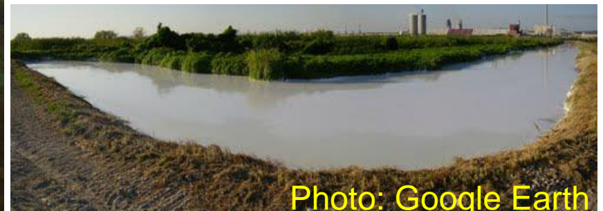
Phosphogypsum storage ponds
